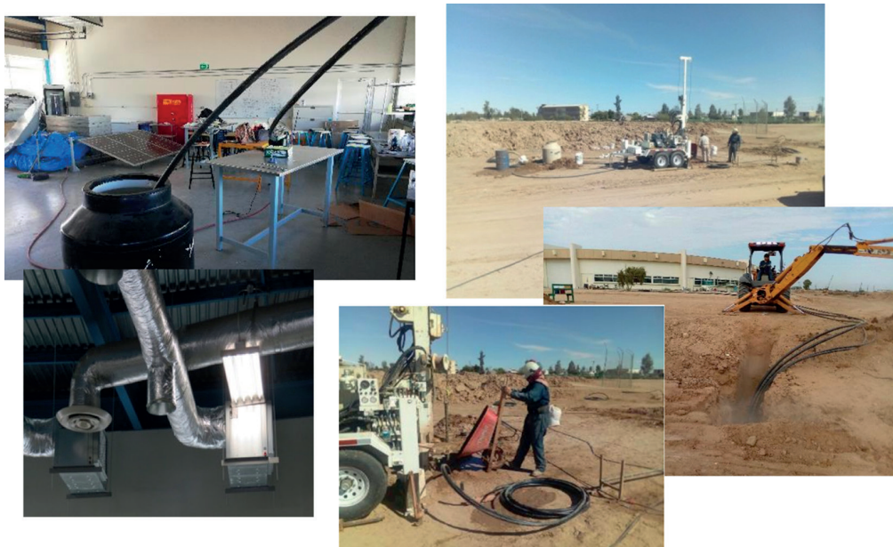
Figura 34. Preparación del terreno para la instalación de los intercambiadores de calor en trincheras horizontales y en pozos verticales. Vistas de las trincheras, de la perforadora del SLE-CICESE y del laboratorio climatizado en la UPBC, Mexicali. Torres Luna, INEEL.
