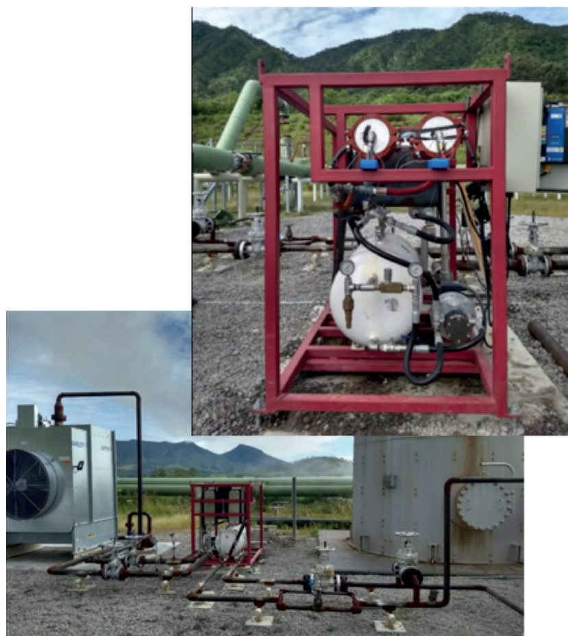
Figura 22. Planta generadora de 10 kWe con ciclo binario instalada en el Domo San Pedro, Nayarit, Aviña et al. , IINGEN, UNAM.
