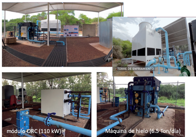
Figura 23. Planta piloto experimental de uso en cascada de energía geotérmica. El prototipo consiste de una planta de generación eléctrica con ciclo binario y una máquina para fabricación de hielo. Rubio Maya, UMSNH.
